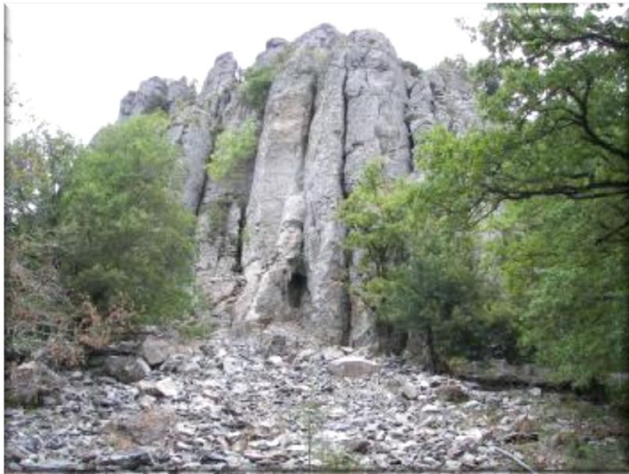
Eboulement site escalade
